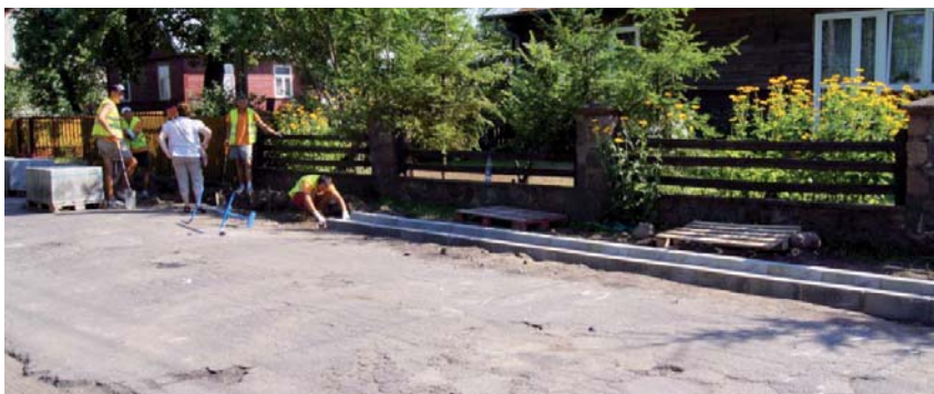
Najdroższe w tym roku zadanie drogowe powiatu sokólskiego jest w trakcie realizacji
