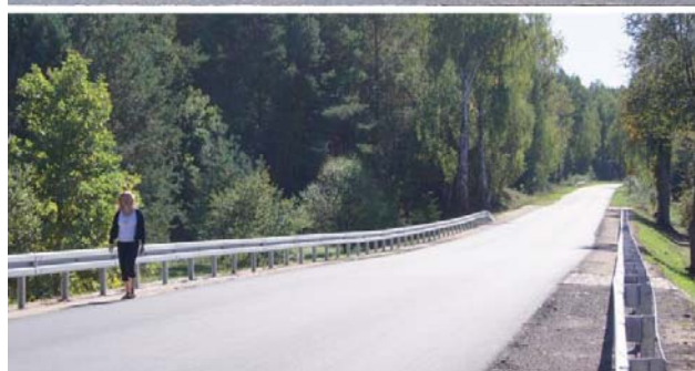
Przebudowa mostu na cieku bez nazwy w ciągu drogi powiatowej nr 1282B Krynki-Kruszyniany
