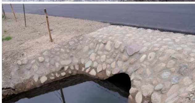
Droga powiatowa Karpowicze-Suchowola remontowana w ramach dotacji z budżetu państwa na usuwanie szkód powodziowych
