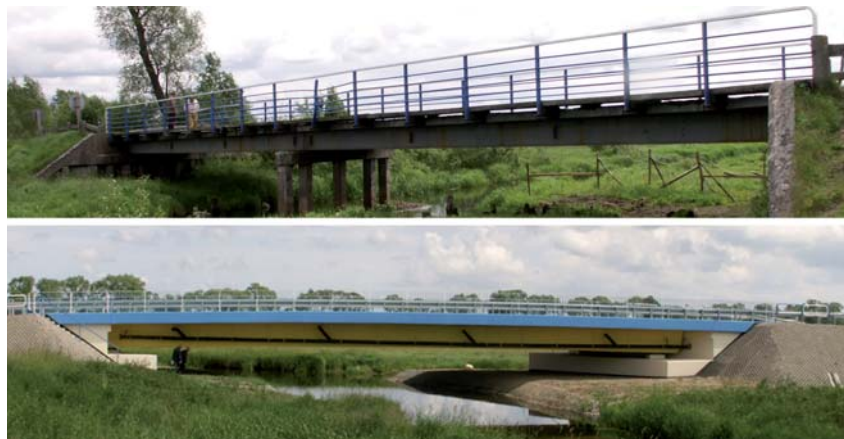
Most w Karpowiczach przed i po przebudowie
